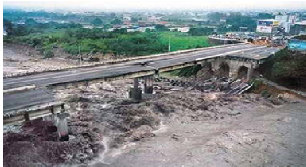
圖 1. 二零零九年辛樂克颱風，台中后豐大橋遭沖毀[6]
